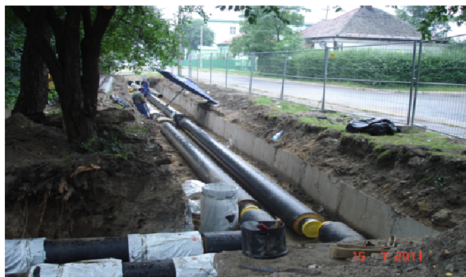
Ryc. 18 Ciepłociągi w technologii preizolowanej
