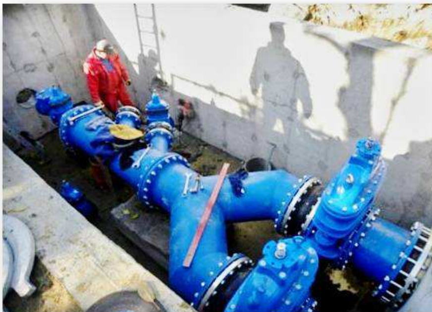
Ryc. 14 Poprawa gospodarki wodno-ściekowej
