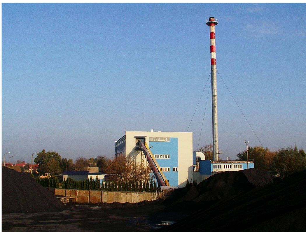
Ryc. 16 Budynek kotłowni K-15 przy ulicy Rzecznej 1A
