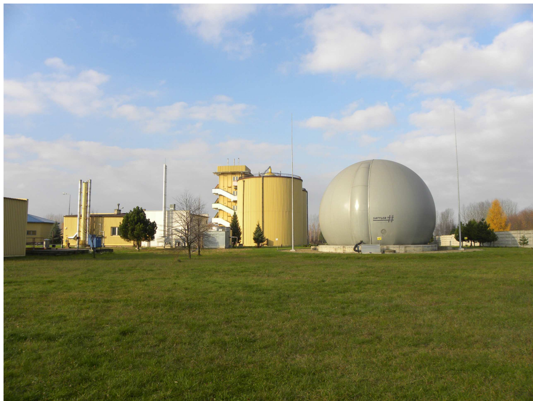
Ryc. 15 Poprawa gospodarki wodno-ściekowej
