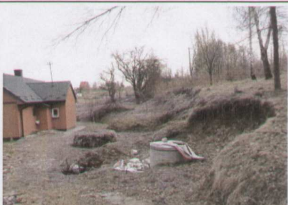
Fot.3 Skarpa główna ( północna część osuwiska)
