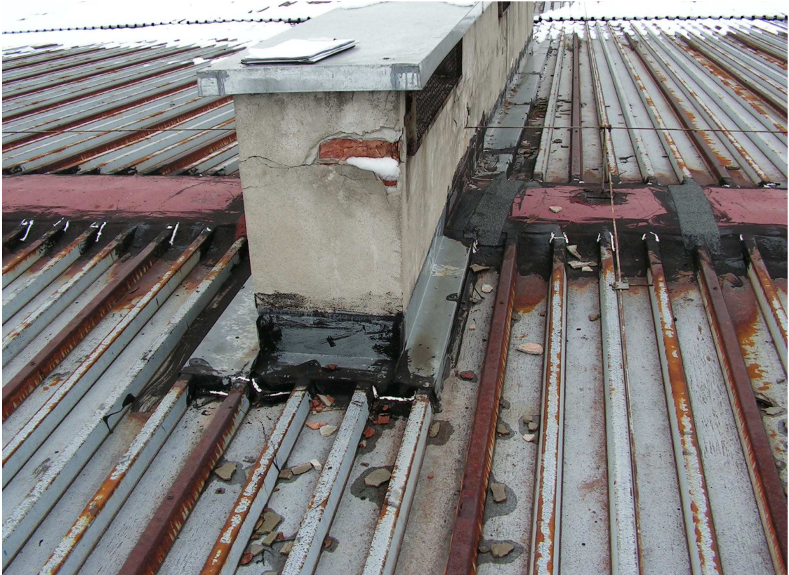
Rys. 4-2. Widok blachy górnej przy kalenicy nawy o rozpiętości 24 m.
