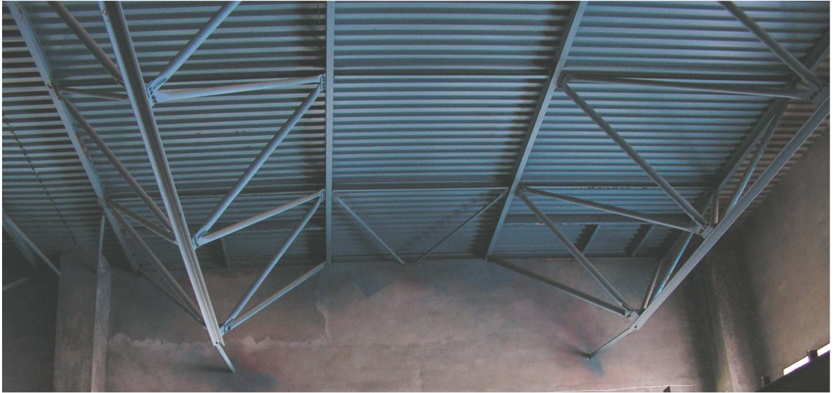
Rys. 5-1. Para wiązarów kratowych w segmencie o szerokości 12 m.
