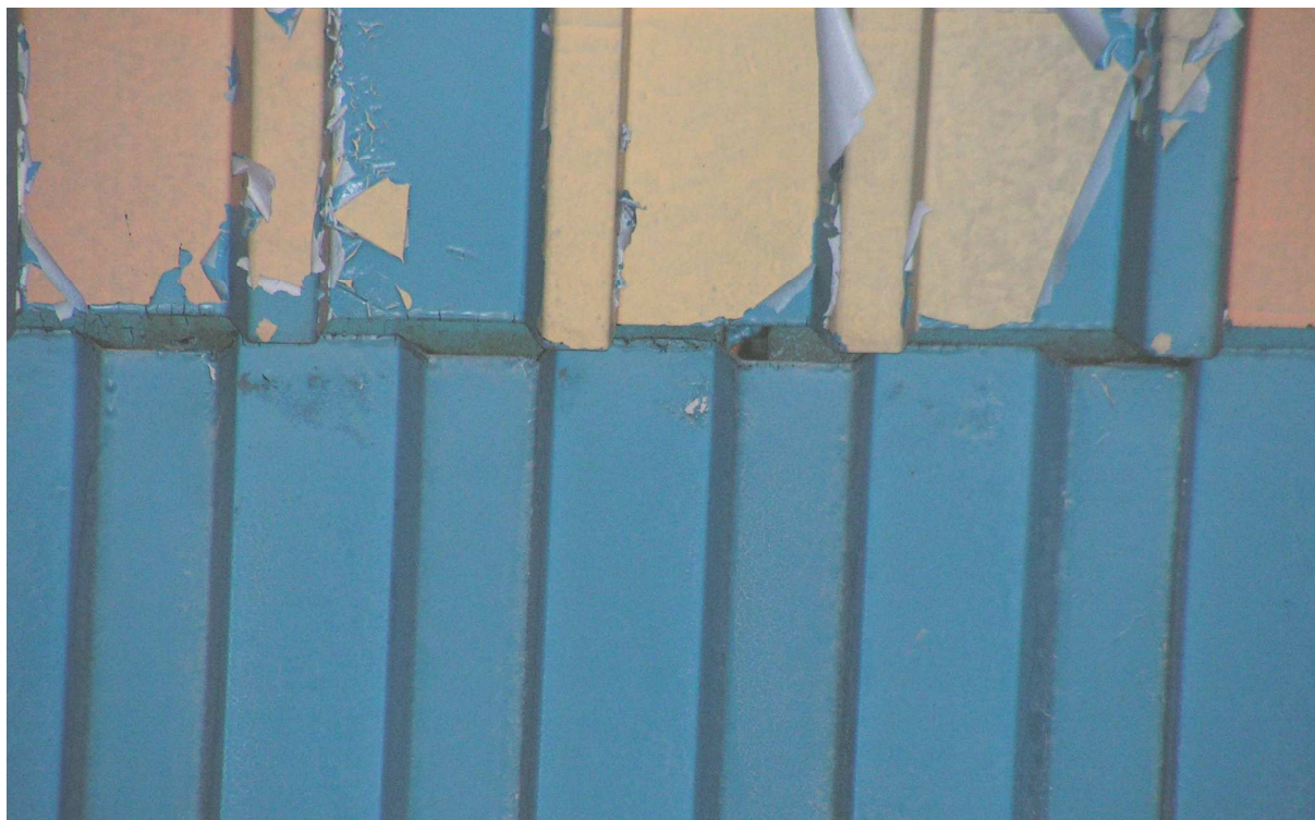
Rys. 4-1. Blacha dolna w części nieużytkowej obiektu. W górnej części rys. blacha T55 w dolnej blacha Ekotal.
