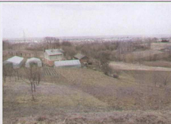
Fot.2 Rzeźba wewnątrz osuwiska (widok na część południową osuwiska)
