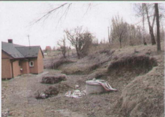
Fot.3 Skarpa główna ( północna część osuwiska)
