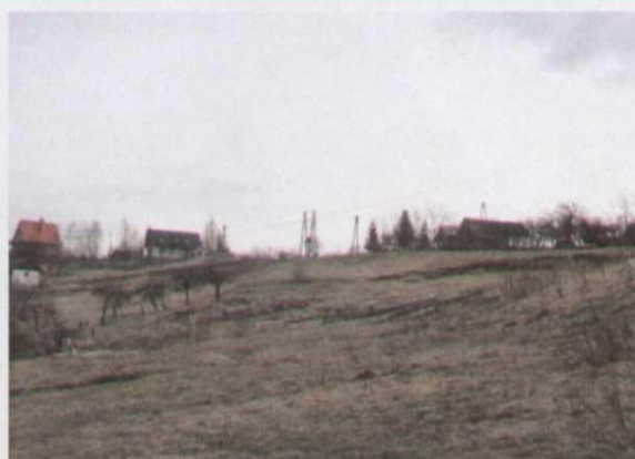
Fot.2 Skarpa główna oraz rzeźba wewnątrzosuwickowa (południowa część osuwiska)
