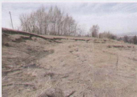
Fot. 1 Skarpa główna (południowa część osuwiska)
