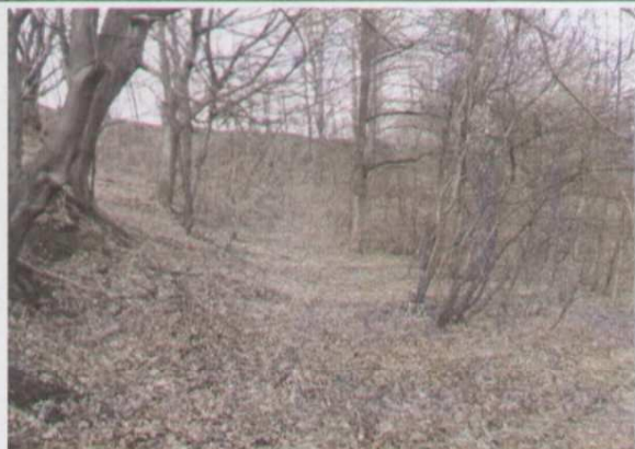
Fot. 1 Skarpa główna (północna część osuwiska)
